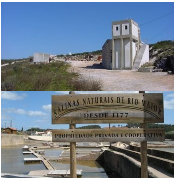
Edifício do CISGAP (@ Olímpio Martins) | Marinhas de sal (@ Cristina Girão Vieira).
