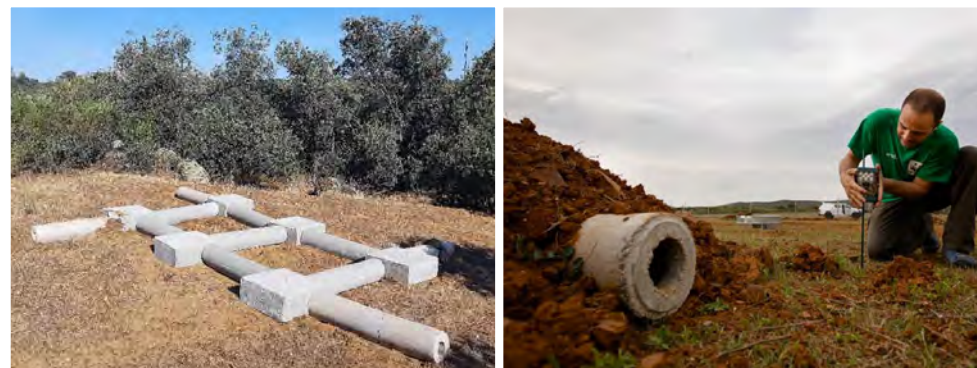
Figura 44. Os marouços e abrigos com tubos e câmaras de betão podem ser montados à superfície e depois cobertos com terra, dependendo do tipo de solo (foto 1 FCBDH e foto 2 WWF-Espanha).
