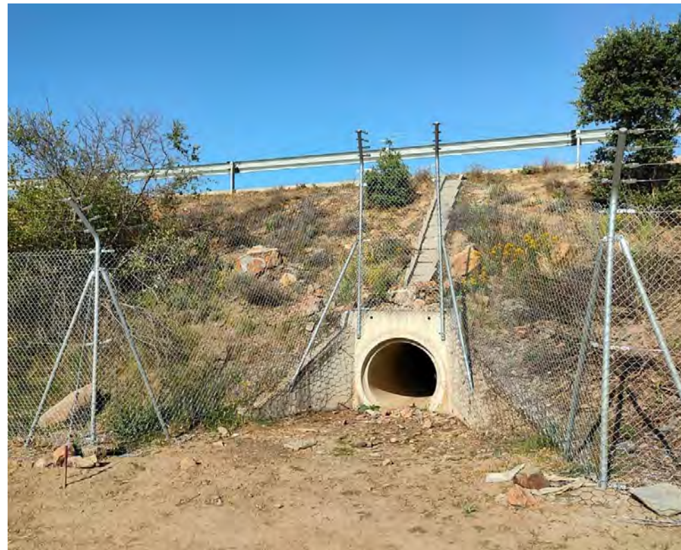
Figura 59. Tubo adaptado como passagem de fauna numa estrada onde existe o risco de atropelamento de lince ibérico. As avaliações da utilização de passagens subterrâneas indicam que há respostas comportamentais positivas dos coelhos, especialmente no verão, se estas forem estreitas, próximas do pavimento, em zonas abertas, com poucos prados e matos nas proximidades ou longe das zonas urbanas (foto FCBDH).
