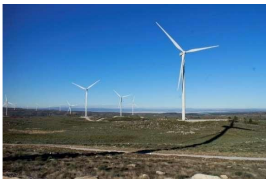
Figura 5 - Sub-Parque Eólico de Sernancelhe.
