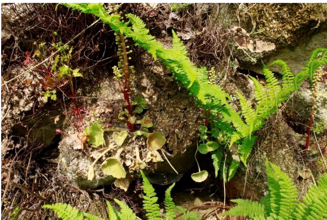
Figura 14- Muros junto à azenha colonizados por vegetação rupícola e fissurícola.
