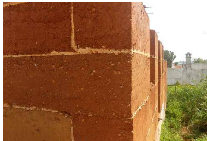
Construção em taipa - FA
