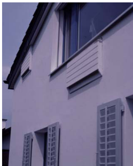
Figura 15 – Fotografia de caixa-abrigo colocada na parede de um edifício (Andres Beck).
