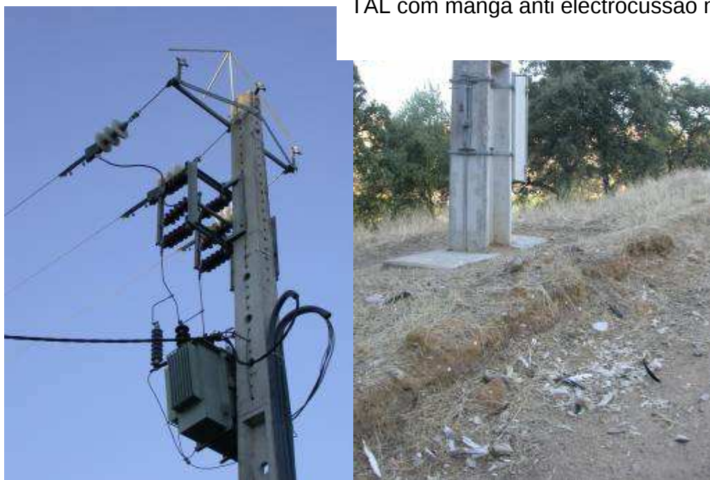
Imagem 5 e 6 – Apoio tipo PT no PNTI com mangas anti electrocussão e arcos isolados onde ocorreu electrocussão de Cegonha Branca.
