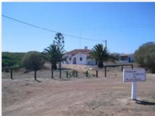
Foto 7- Casa do Guarda Florestal
