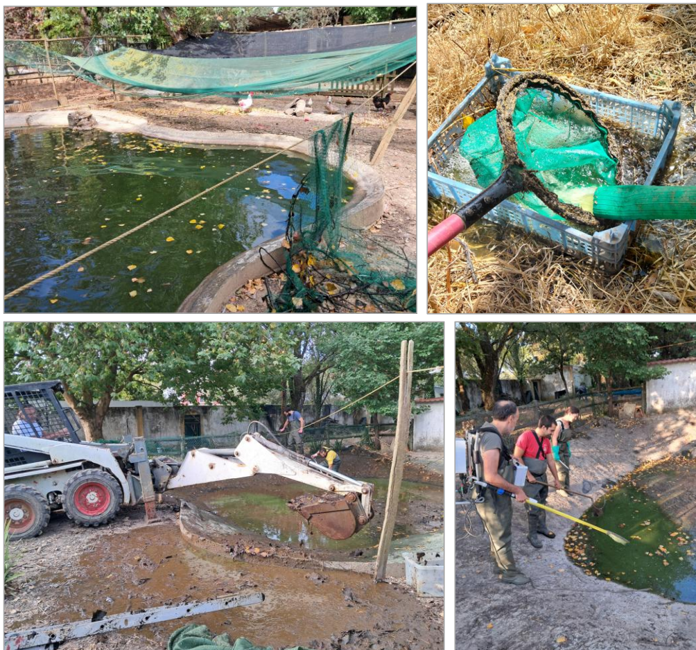
Figura 7. Drenagem e limpeza de tanque privado
