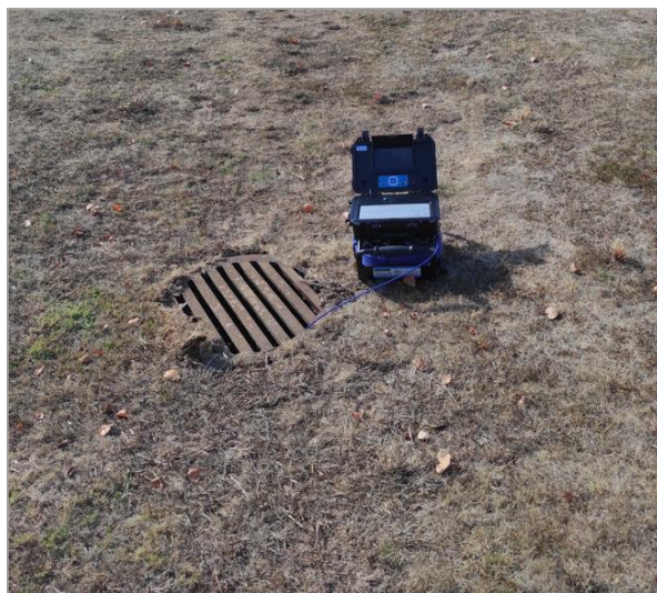
Figura 15. Prospeção do interior das condutas com recurso a sonda
